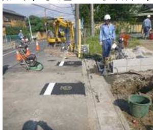
写真-8 施工完了
