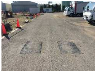
写真-6 施工完了
