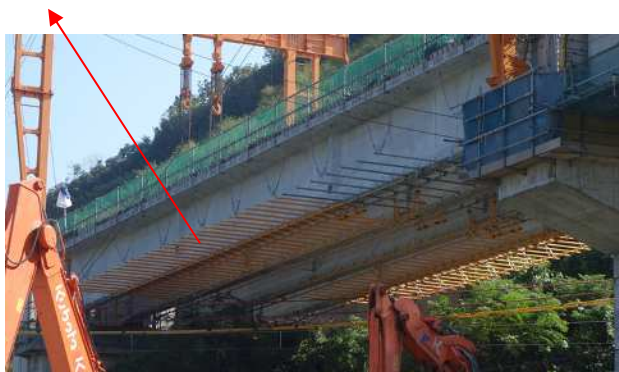
(写真-①) 【跨線橋現場写真】
