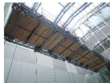
写真-7 4点吊りの様子
