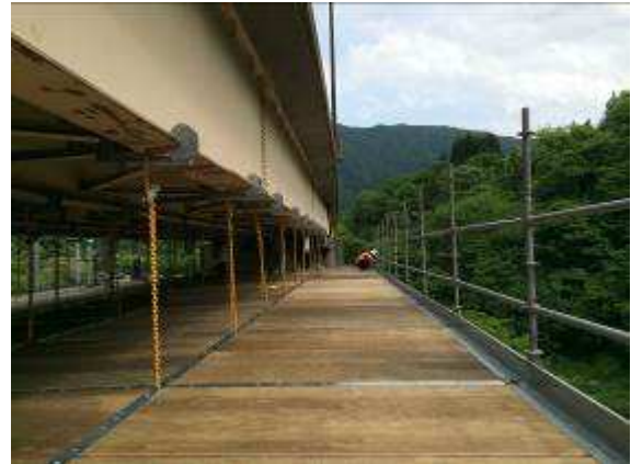
写真-2 採用例 (内部)
