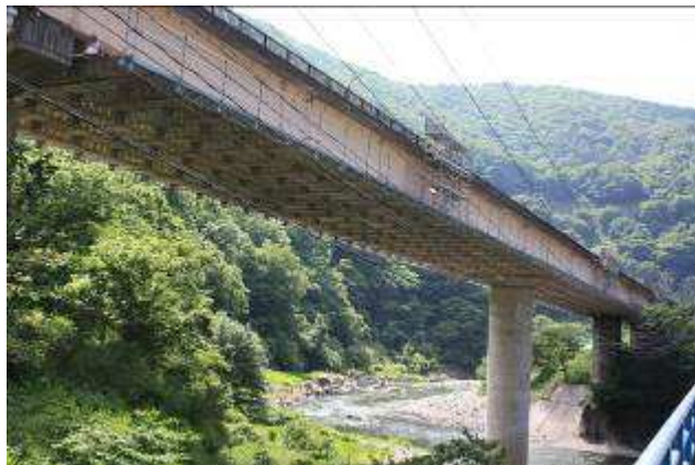
写真-1 採用例 (橋梁)
