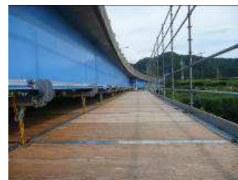
写真-5 従来の跳ね出し 写真-6 2.5m 跳ね出しの様子
