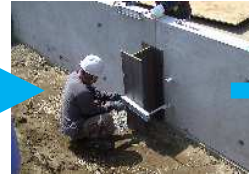
4. 接続金具固定
