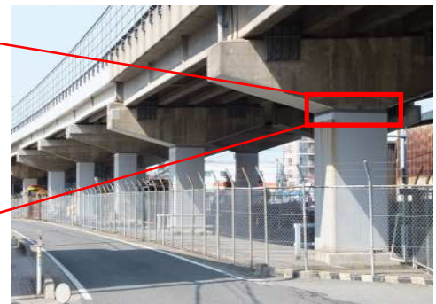
写真-13 鋼板巻き立て全体図
