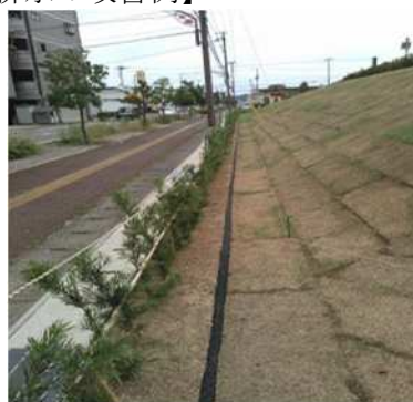
写真-4 法面施工直後
