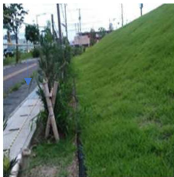
写真-5 法面施工約3ヶ月後
