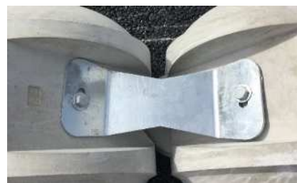
写真-5 鋼製連結プレート
