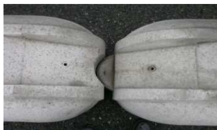
写真-4 かみ合わせ構造
