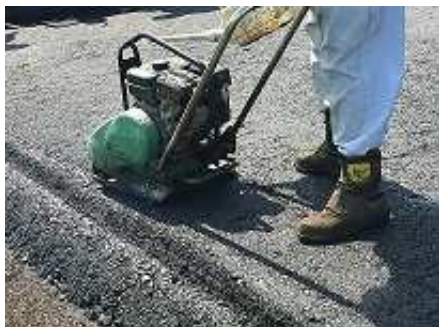
写真-6 舗装機械
