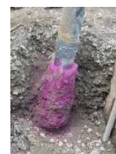
写真-6 礫地盤 施工状況例
