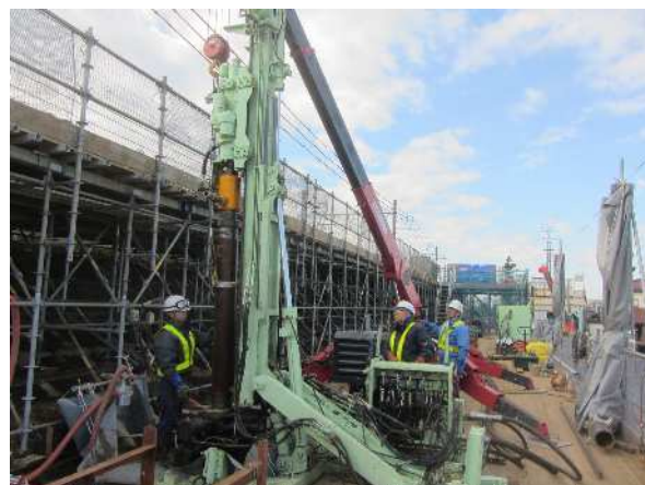
写真-1 足場上での施工状況
