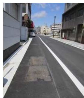
【図 5：車道幅が狭く歩道部分に車が乗り入れてくる様な所に施工された例】
