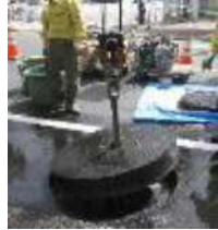
写真-15 仮蓋撤去
