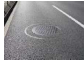
写真-17 排水性完了
