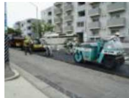
写真-6 仮埋め 写真-7 アスファルト切削 写真-8 アスファルト舗設 写真-9 カッター刃
