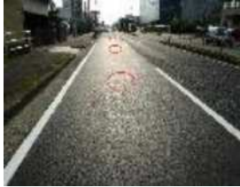
写真-14 舗装完成
