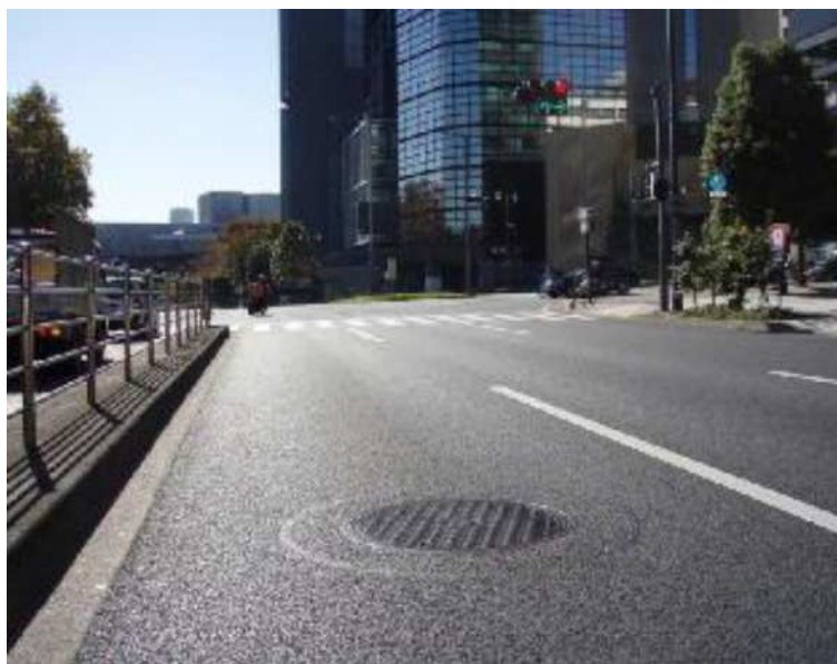
写真-1 セイフティーフラット工法 (P-B工法)
