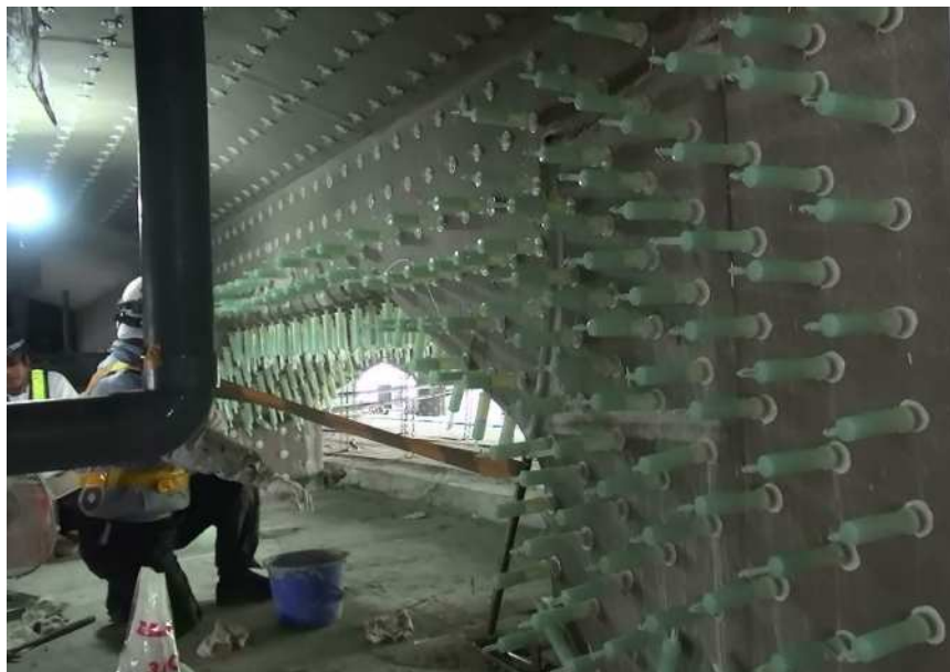
写真-1 施工状況
