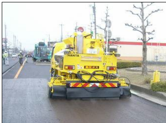
写真-1. スーパータックゾールの散布状況
