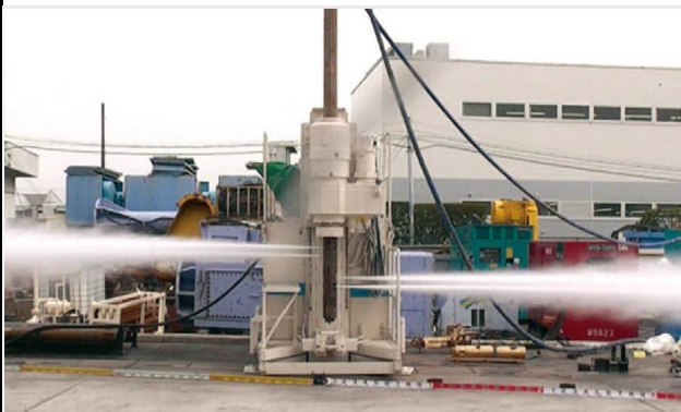
写真1.1 ツインノズルによる気中噴射状況
