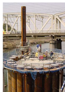
図4 井筒鋼管矢板基礎
