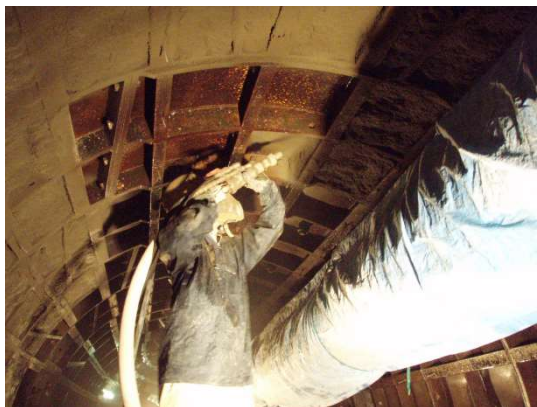
写真1 TDR ショットライニングシステムによる吹付け状況（充てんモルタル）
