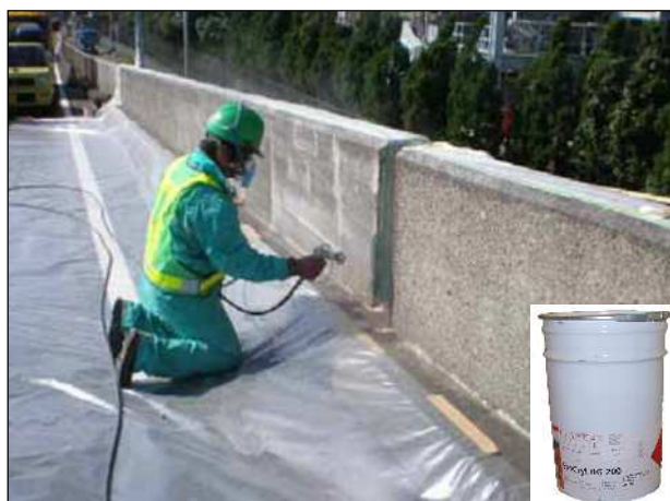
写真-1 表面含浸材 塗布状況
