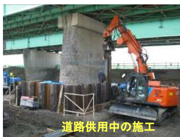
写真-5 シートパイル打設状況
