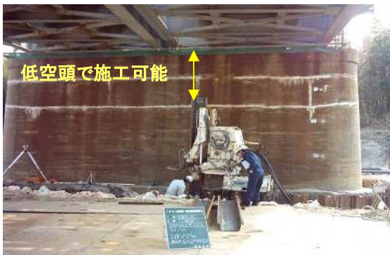
写真-3 シートパイル打設状況
