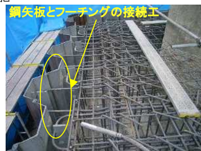
写真-6 フーチング結合部鉄筋組立状況
