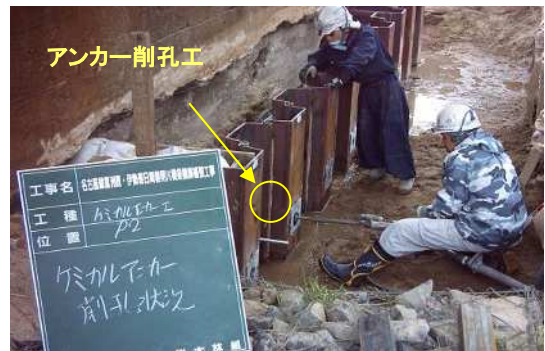
写真-4 フーチングアンカー削孔状況
