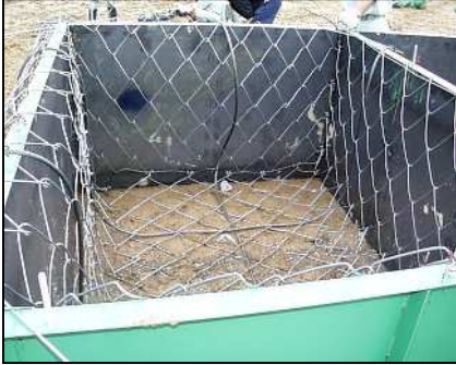
写真-2) 型枠設置
