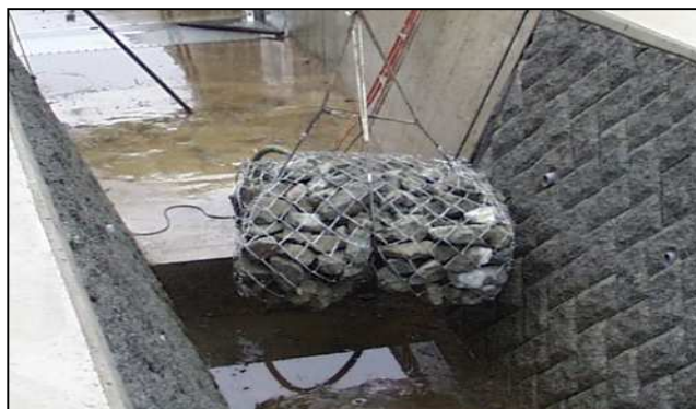
写真-1) 根固めマット (水中施工状況)
