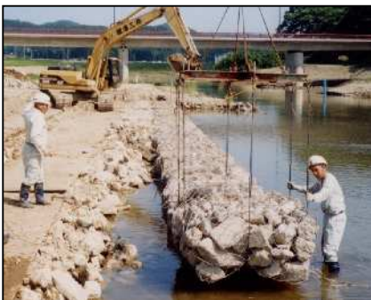
写真-6) コンクリート殻使用によるリサイクルの促進事例
