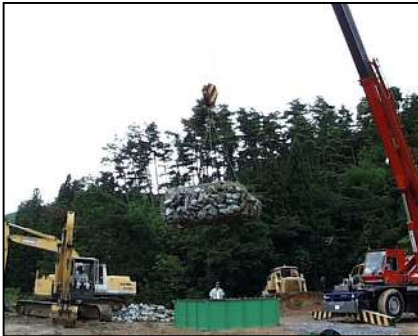
写真-4) 吊上げ・転置
