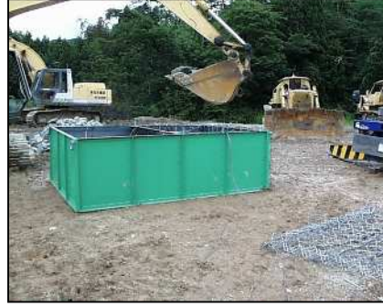
写真-3) 中詰め材投入
