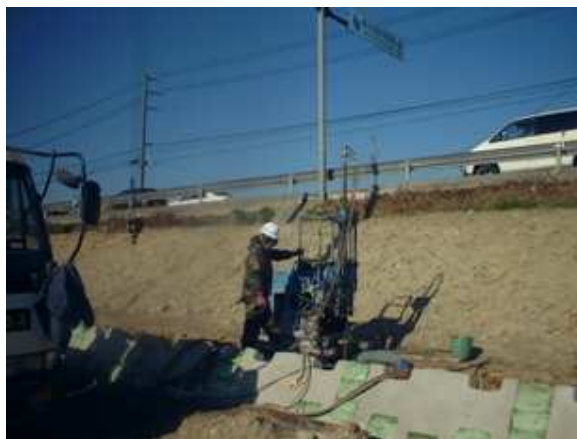
写真-1 特殊注入管設置状況
