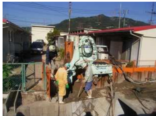
写真-5 狭隘な場所での施工
