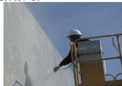
写真1 表面含浸工法塗布状況写真
