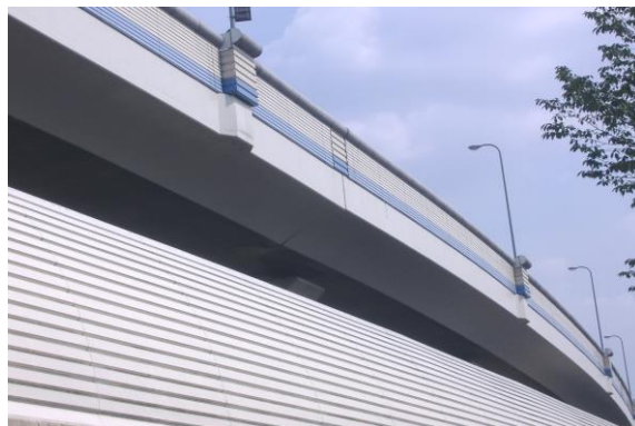
写真-1 側壁・張り出し下面コンクリート部へのライフテックスSDK-C工法の施工例
