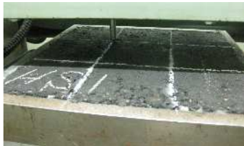
静荷重載荷試験状況
