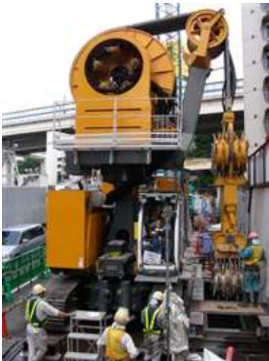
作業帯占有幅 6m での施工状況
