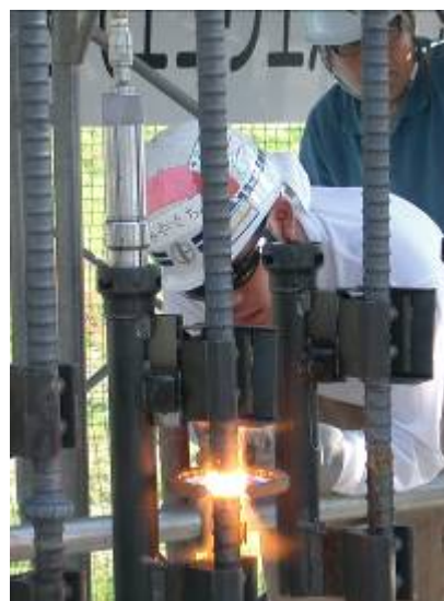
写真-3 エコウエルガス圧接作業風景
