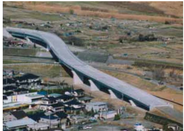
戸川橋床版工事（凍結防止剤対策）
