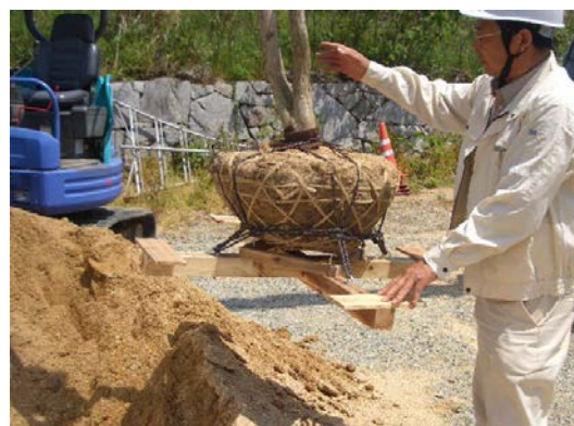
支柱取付け後の吊上げ作業が可能 作業効率が大幅に向上
