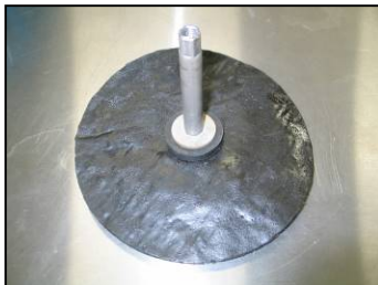
加圧調整パイプ取付状況
