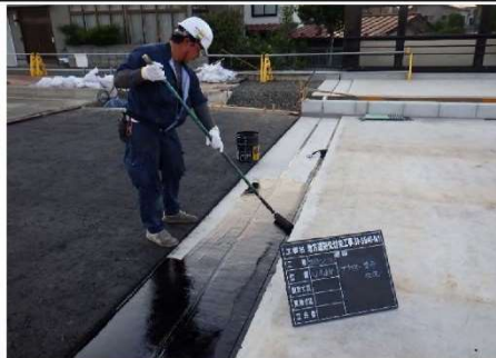
2.プライマー塗布
