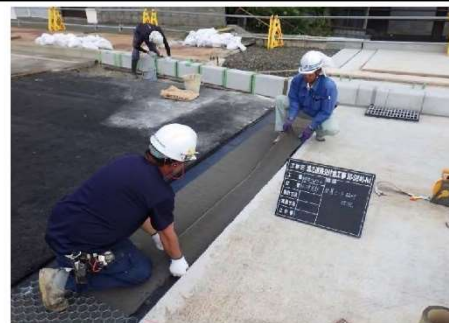
5.定着シート貼付
