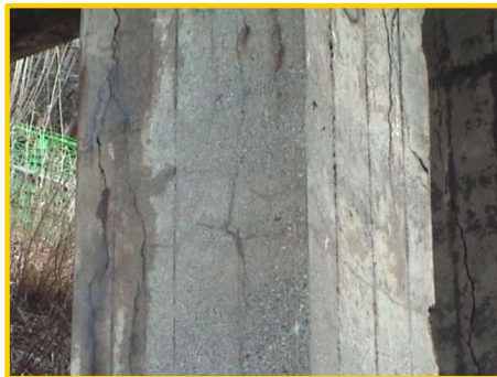
脱塩を適用しなかった橋脚の状況 旧国道8号線洞川橋経年比較
