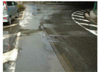
供用2ヶ月時点（雨天時）
