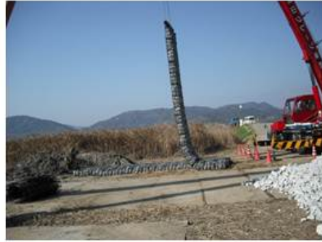
6.吊上げ・仮置き
