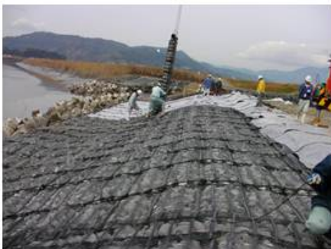
8.吊上げ・本設置
