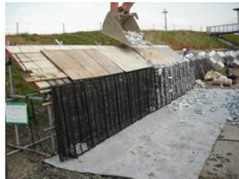
4.ジオシェルトン底部縫合・中詰材充填
