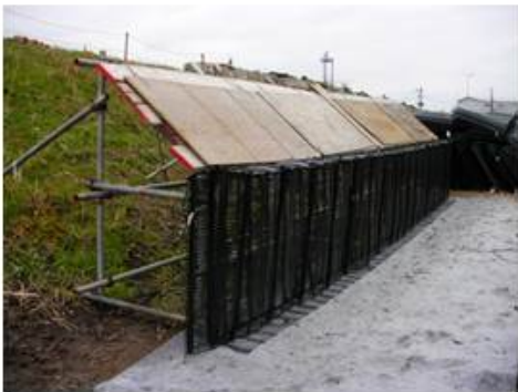
3.中詰材充填用架台の設置
