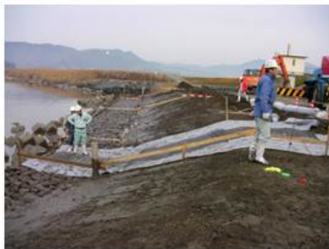
7.吸出し防止材の設置
