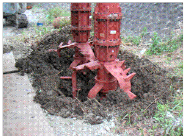
写真-5 \phi 1,600\text{mm} \times 2 軸 施工状況
