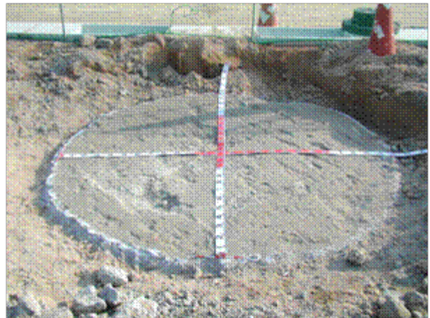
写真-3 \phi 2,500\text{mm} 出来形
