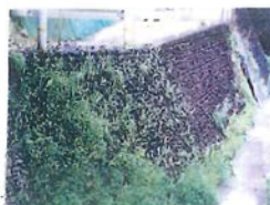
製品2. 溶岩パネル (張り、残存型枠兼用) 300×900× 質量26kg
