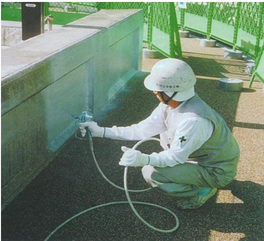
ダム堤体高欄
