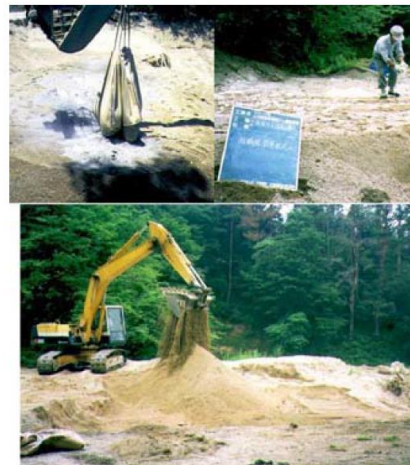
スケルトンバケットによる混合 (岩村ダム適用事例)
