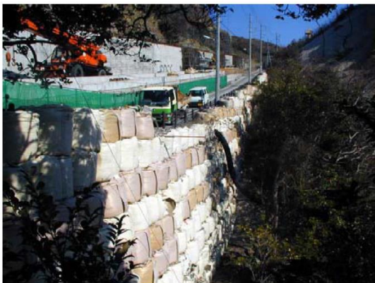
【東京都 神津本道道路災害復旧工事】
