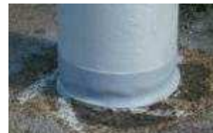
施工後：補強した鋼管柱
