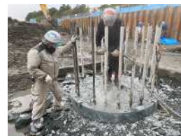
写真-2 ハンドブレイカーによるはつり作業
