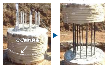
写真-1 凍結杭頭処理工法による杭頭処理
