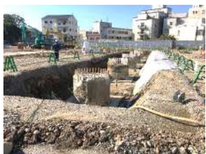
⑤根切り工事完了
