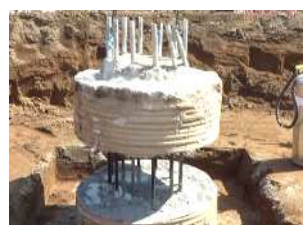
⑦余盛りのコンクリート撤去
