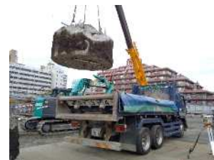
⑨余盛りコンクリート搬出
