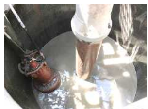
④トレミー管挿入・コンクリート打設状況
