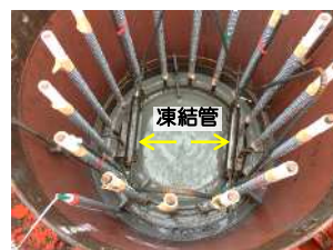
③鉄筋かご建込み状況
