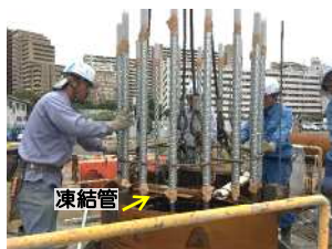
②凍結管取り付け状況
