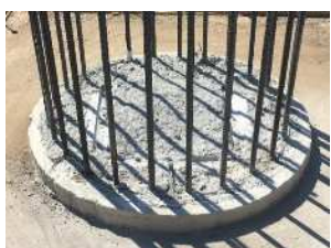
⑧余盛りのコンクリート撤去完了
