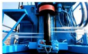
円形改良(2方向4ノズル喷射)
