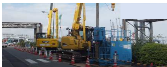
施工機械全景
