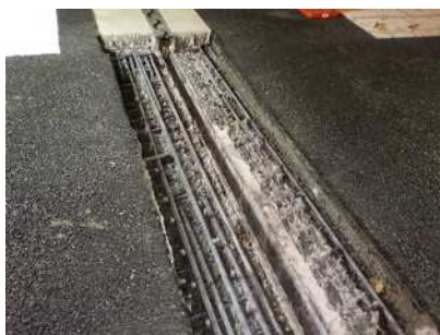
写真-6,7 オートチップパーによるはつり面 (ジョイント後打ちコンクリートはつり(左)、 コンクリート床版はつり(右))
