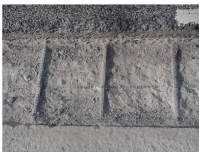
写真-5 ブレーカーによるはつり面
