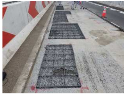
写真-6,7 オートチップパーによるはつり面 (ジョイント後打ちコンクリートはつり(左)、 コンクリート床版はつり(右))
