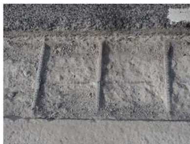
写真-5 ブレーカーによるはつり面
