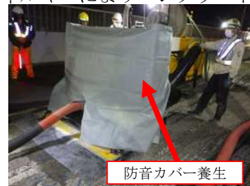
写真-4 夜間施工状況
