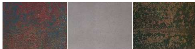
錆原板 1種ケレン 3種ケレン ケレン処理の前後(写真-6)
