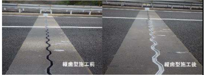
REJ工法の施工前後(写真-4)
