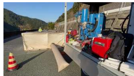
バキュームブラスト機設置状況（写真-2）
