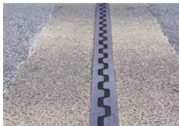
図-2 横歯型伸縮装置 遊間シール充填方法
