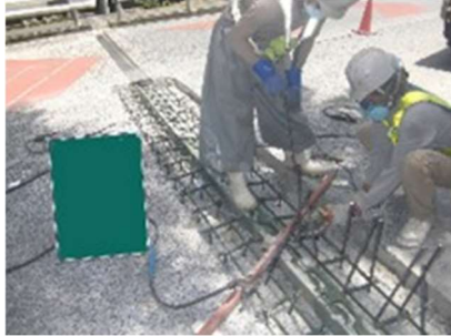
従来工法はつり作業(写真-3)
