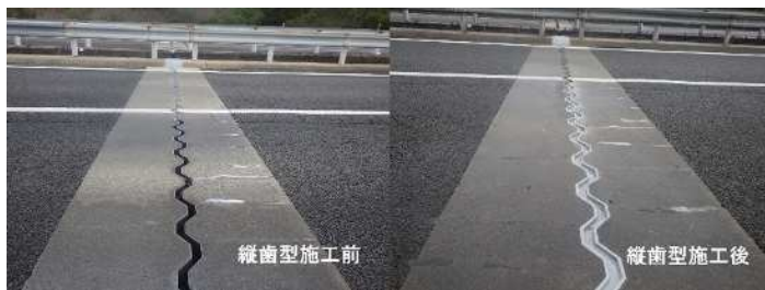
REJ工法の施工前後(写真-4)
