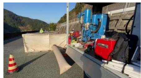
バキュームブラスト機設置状況（写真-2）
