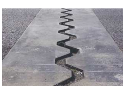
図-1 縦歯型伸縮装置 遊間幅別シール充填方法
