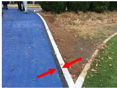
写真-3 舗装端部の状況
