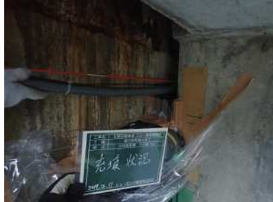
写真-6 側方型充填工(床版切削無)
