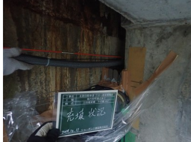
写真-6 側方型充填工(床版切削無)
