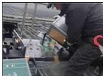
写真-2 弾性シール材充填工
