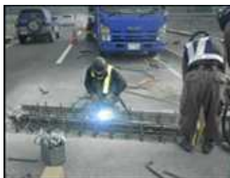
写真-3 伸縮装置取替工
