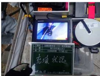
写真-8 充填確認状況
