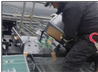
写真-2 弾性シール材充填工
