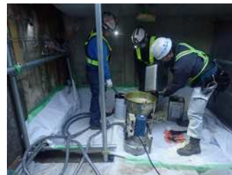
写真-4 桁端部側方型充填工法
