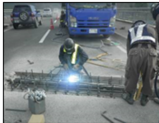
写真-3 伸縮装置取替工
