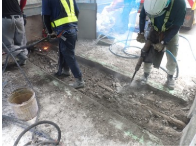
写真-5 伸縮装置取替工(床版切削有)
