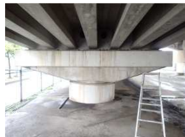
写真-10 側方型充填工法(適用済)
