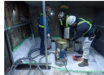
写真-4 桁端部側方型充填工法
