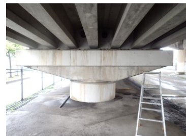
写真-10 側方型充填工法(適用済)
