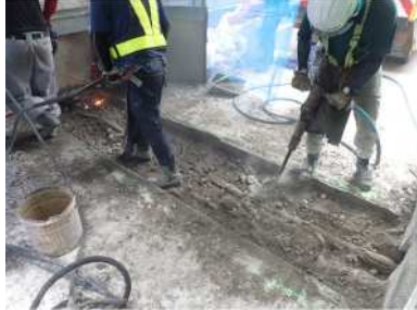
写真-5 伸縮装置取替工(床版切削有)
