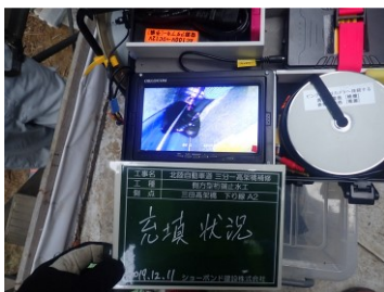
写真-8 充填確認状況
