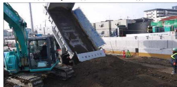
写真-2 関東地方整備局現場納品状況
