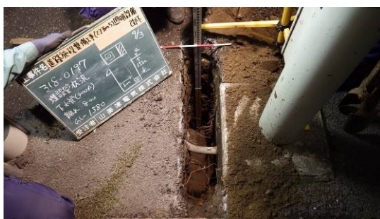
埋設物調査工にて下水道管の確認状況(深さ 1.58m 左：遠景 右：近景)
