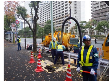
施工状況（街路灯基礎 埋設物調査工）
