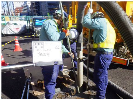
地上からの埋設物調査工
