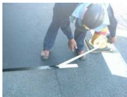
写真-2 シールコート工 既設アスファルトにアステープを貼り付け、剥離紙をはがしているところ
