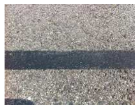
写真-4 アステープによるシールコート施工箇所（施工1年後、滋賀県内県道路面）
