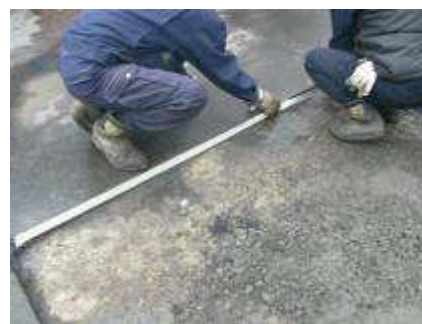
写真-3 サイドタックコート工 打ち継ぎ面へアステープを貼り付けているところ
