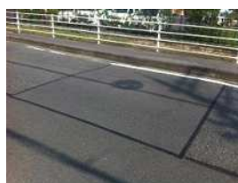
写真-4 アステープによるシールコート施工箇所（施工1年後、滋賀県内県道路面）
