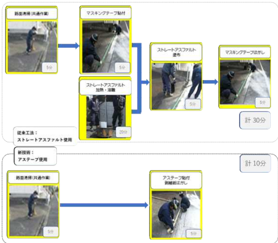
図-1 試験施工による工程比較（シールコート工における端部接着処理50m）
