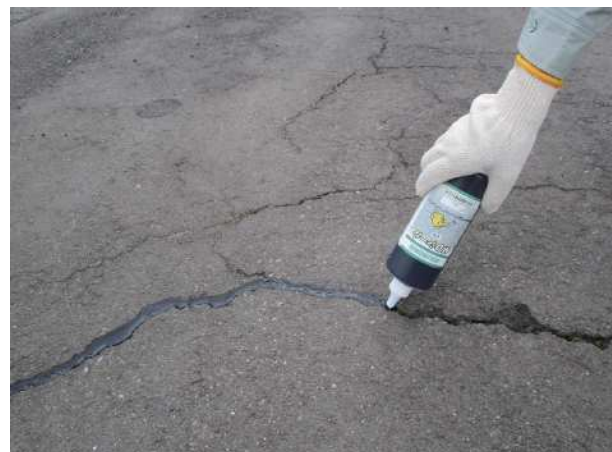
写真-2 注入状況
