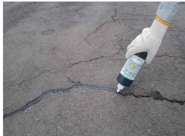
写真-2 注入状況
