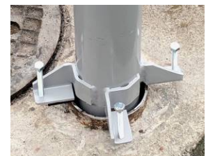
写真3 鉛直調整金具
