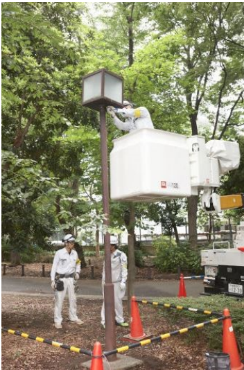
(施工前) 写真1 設置状況
