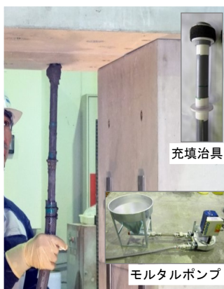
写真-1 上向き施工での充填状況
