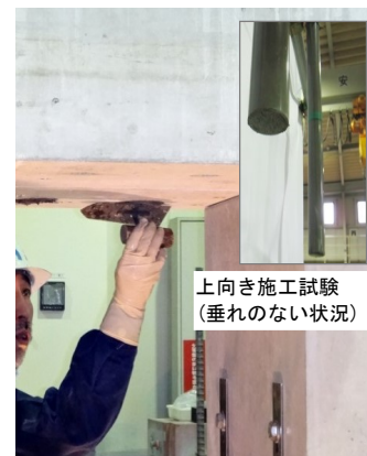
写真-3 表面仕上げ状況
