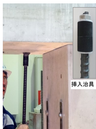
写真-2 上向き施工での挿入状況
