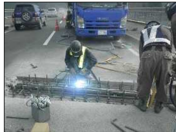
写真-3 伸縮装置取替工
