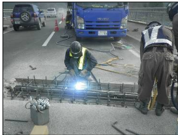
写真-3 伸縮装置取替工
