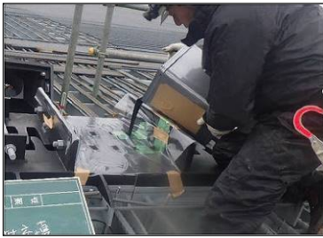
写真-2 弾性シール材充填工
