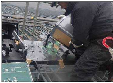
写真-2 弾性シール材充填工
