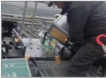
写真-2 弾性シール材充填工
