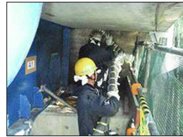
写真-4 プレスアドラー設置
