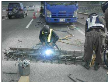
写真-3 伸縮装置取替工
