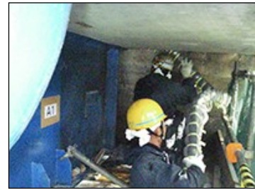
写真-4 プレスアドラー設置
