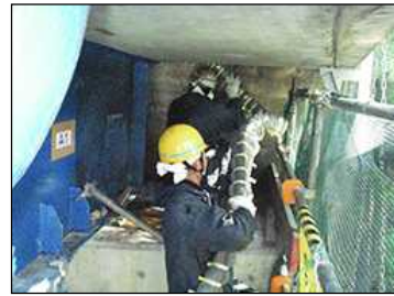
写真-4 プレスアドラー設置
